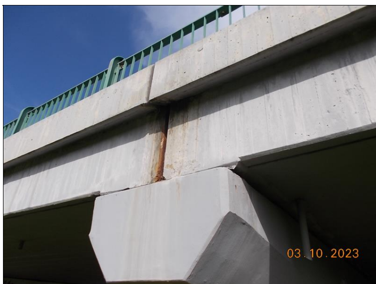
pilíře - zatékání na levé kraje příčniců pilířů,
