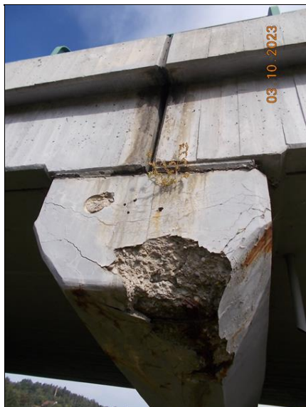
pilíře vlevo - detail značné degradace betonu příčniku, obnažená a korodující výztuž, místy
