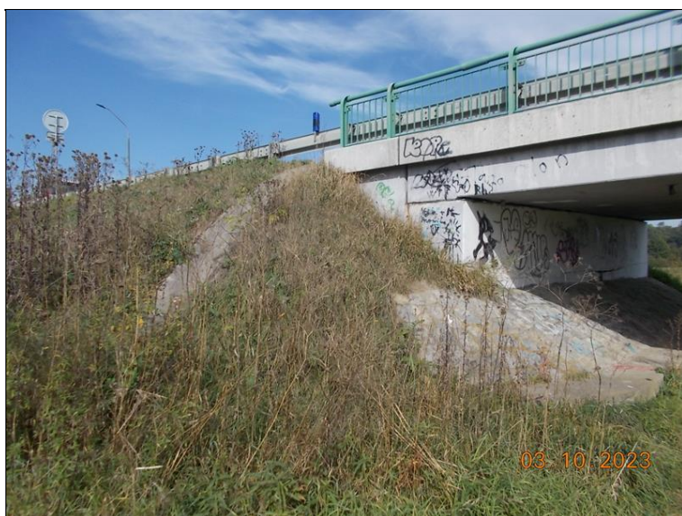
OP8 vlevo - zemní kužel a odv. skluz - vegetace
