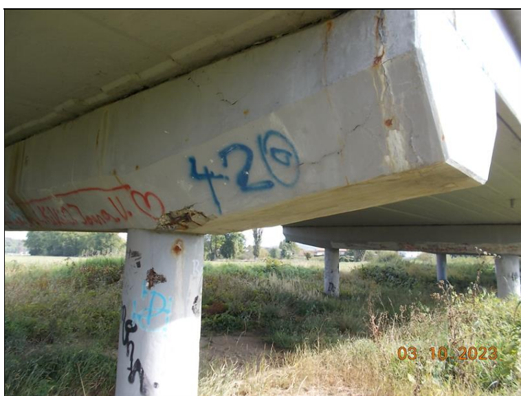
pilíře vlevo (P4,P5, P6) - značná degradace betonu příčniku, obnažená a korodující výztuž, místy podélné trhliny stojek
