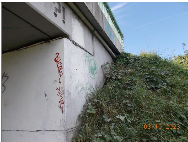
křídlo a zemní kužel OP8 vpravo - vegetace
