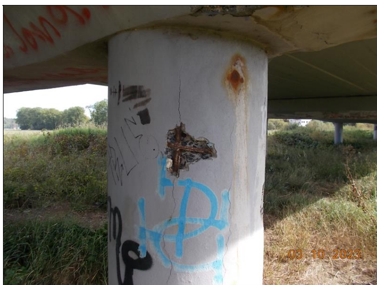
obnažená a korodující výztuž, místy podélné trhliny stojek pilířů
