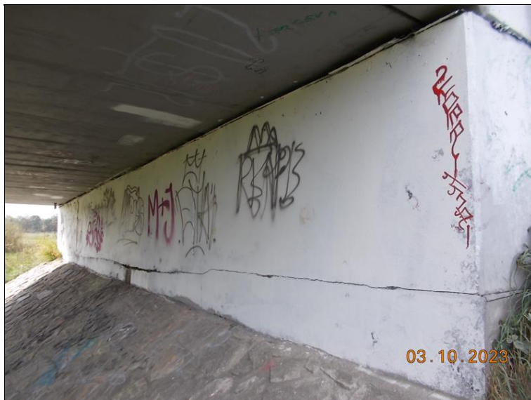
líc OP8 - trhlina v celé šířce
