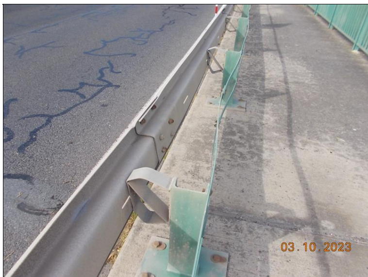
detail poškozených distančních prvků v 1. poli
