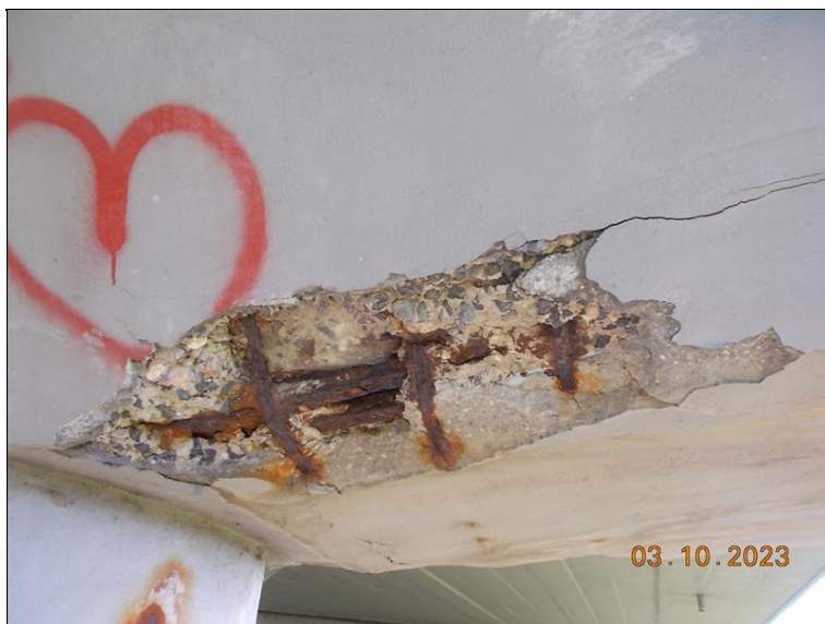
detail degradace betonu příčniku, obnažená a korodující výztuž
